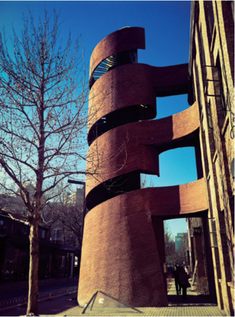
大跨型工业遗产建筑的设施、设备
