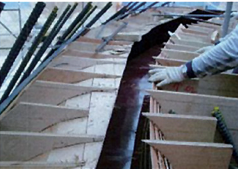
首尔东大门设计广场数字化技术参与异规墙体浇筑
